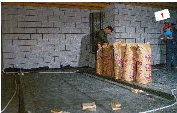
Setzen der Abziehlehren z. B. auf VERMIBIT.
