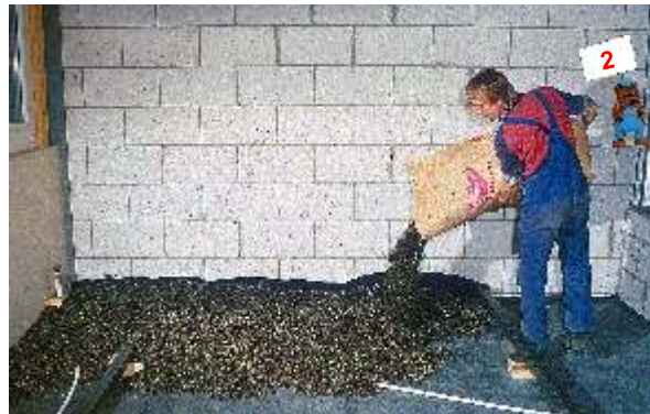
Schütten und verteilen, Mindesthöhe 20 mm.
