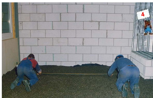
Oberflächenglattes Abziehen von VERMIBIT.
