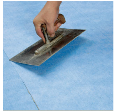
Bahnen mit Traufel, Gummiwalze oder Klopfbrett andrücken.
