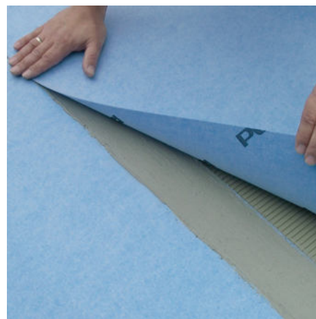
Mit der PCI Pecilastic W können feuchtigkeitsempfindliche Untergründe schnell und sicher abgedichtet werden.
