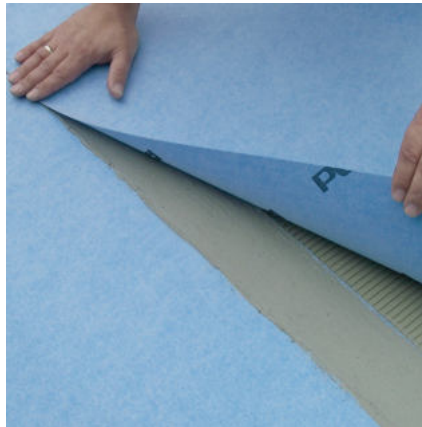
Innerhalb der klebeoffenen Zeit die folgende Bahn einlegen.
