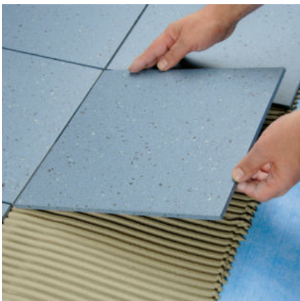
Nach dem Aushärten des Dünnbettmörtels können auf PCI Pecilastic W Keramik- und Naturwerksteinbeläge verlegt werden.
