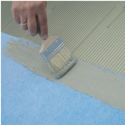
Zum wasserdichten Verkleben der Stöße PCI Seccoral 1K/2K Rapid fehlstellenfrei auf die PCI Pecilastic-W-Bahn aufbringen.
