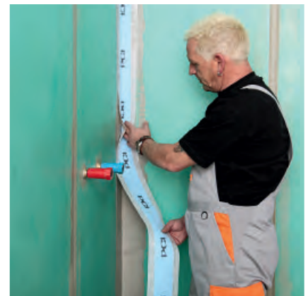
PCI Pecitape wird in die frische Auftragsschicht des verwendeten Abdichtungsmaterials eingebettet.
