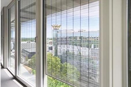
Für die Blendfreiheit und eine ausreichende Verschattung der Arbeitsplätze sorgen der motorisch betriebene, systemintegrierte Blendschutz Schüco Integralmaster sowie der außenliegende rollbare Sonnenschutz Schüco CSB.
