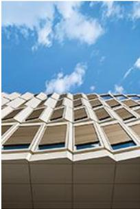
Spannende visuelle Effekte erzeugt die Struktur der Hauptfassade des Schüco One Neubaus, indem sie sich wie eine Ziehharmonika auf und zu faltet. Die Fassade wurde als Sonderkonstruktion mit 90 mm Bautiefe entwickelt, basierend auf dem Schüco Fenstersystem AWS 75.SI+.
