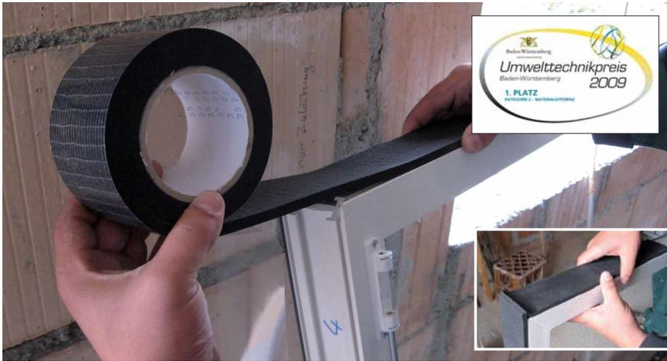
**Fugendichtungsband für die gleichzeitige innere und äußere Abdichtung und Dämmung von Fenster- und Türfugen.**
